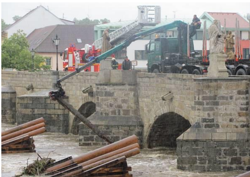
Čištění průtoku pod „Starým mostem“ v Písku dne 2. 6. 2013 odpoledne
