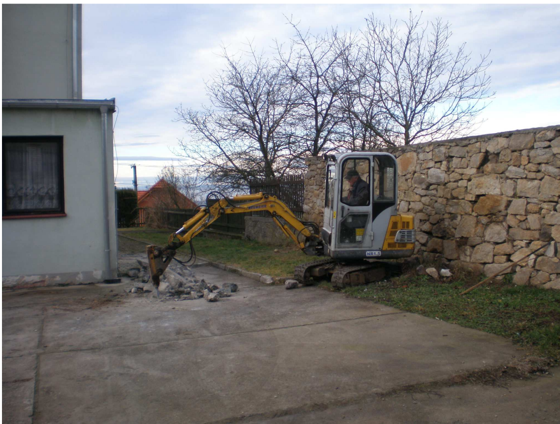
Výkopové práce pro kanalizaci ve dvoře penzionu "Václavka" prováděna p. Motyčákem
